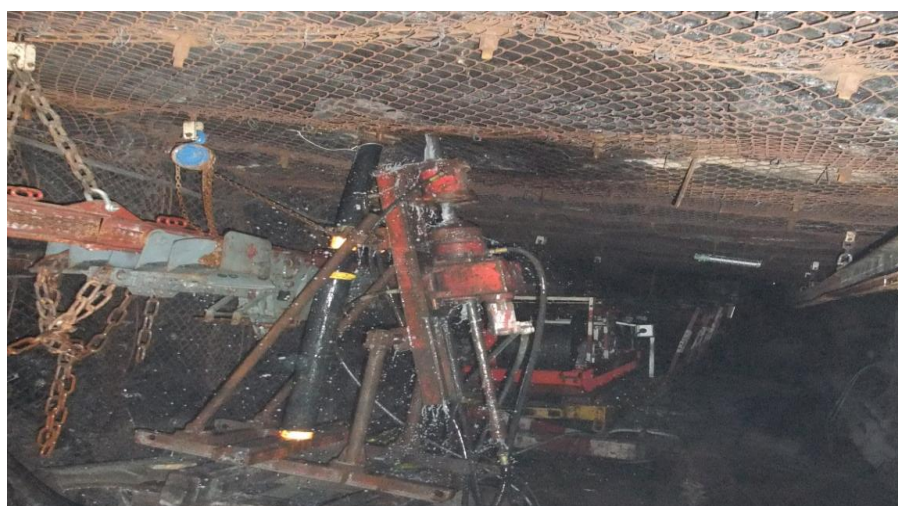
定向水力致裂原理及现场实施情况
