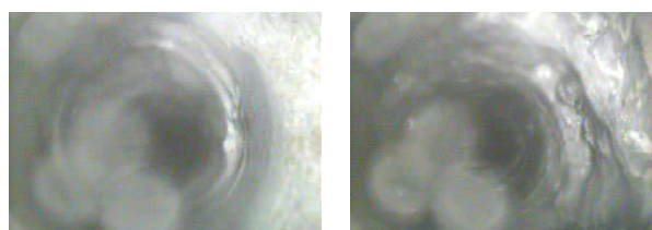
(a) 顶板 8.0 m 深处
