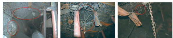
(a) 巷道坏围岩变形 (b) 围岩层裂垮落 (c) 锚杆冲击拉断
