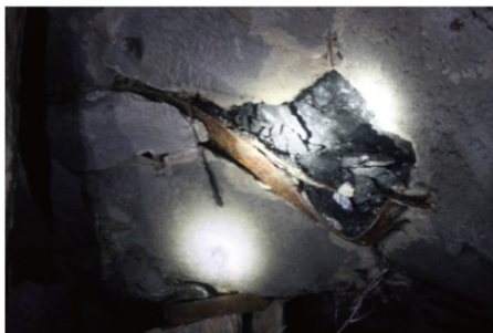
(c) 泄水巷现场图片
